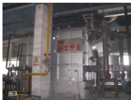
图3/ 佛山扬戈炉业有限公司在亚洲铝业有限公司开展的蓄热式熔铝炉改造项目 Foshan Younger Furnace Co., Ltd. Installed Heat Storage Aluminum Melting Furnace for Asia Aluminum Co., Ltd.
